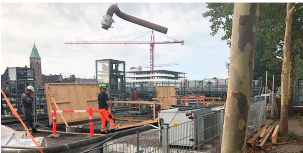
Udskiftning af ventiler skete med stor præcision efter at en flere kilometer lang rør-strækning var tømt for varmt vand.
