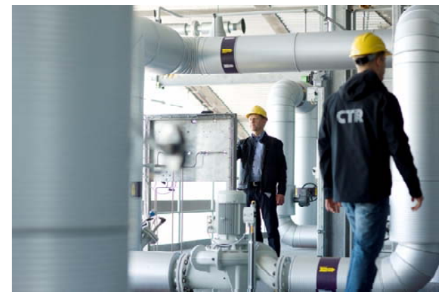
Fjernvarme nettet overvåges døgnet rundt.
